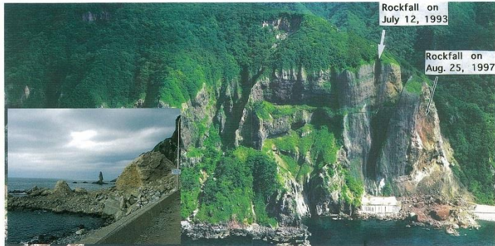
第3図、海に落ち込んだ岩盤増落土砂、
